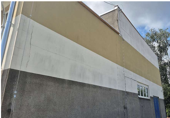
Zdj. 2 Elewacja ściany szczytowej, liczne spękania.
