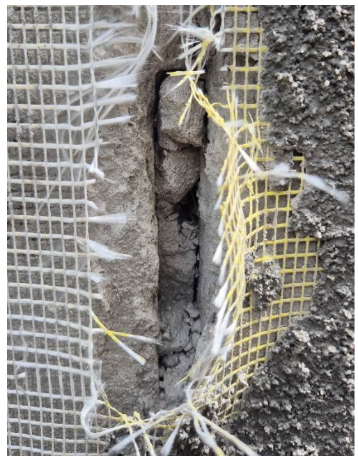
Zdj. 7 Rozwarstwienie i pęknięcie tynku z odsłonięciem siatki zbrojącej i warstwy podkładowej, powstanie szczeliny (ok. 2cm).
