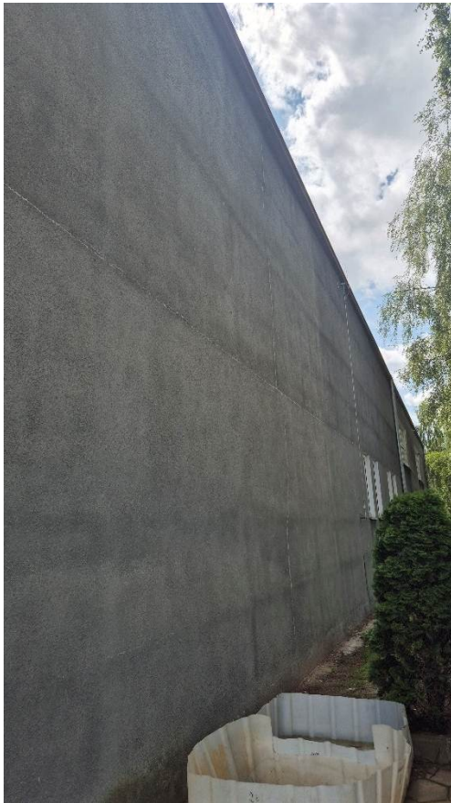
Zdj. 4 Elewacja tylna, pęknięcia na łączeniu płyt prefabrykowanych.
