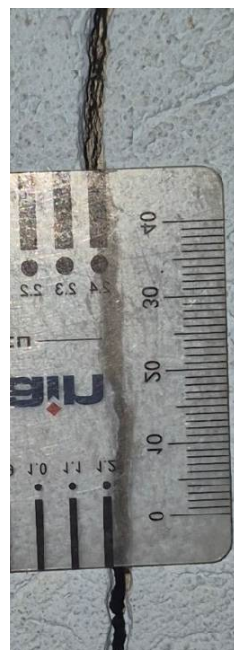
Zdj. 13 i 14 Pom. techniczne nr 2 - rysy i pęknięcia (m. in. 2,4cm) wraz z uszkodzeniem ciągłości warstwy tynkarskiej
