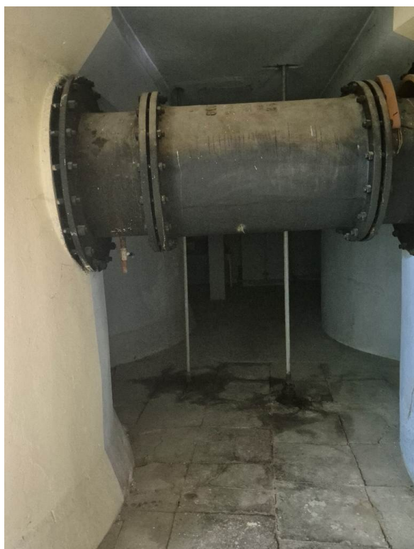
Zdj. 9 Kondygnacja parteru hali mieszania - zacieki na posadzce
