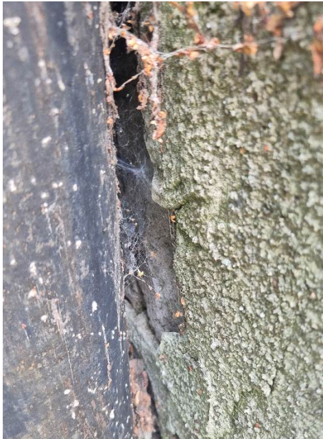
Zdj. 6 Ubytki tynku w ścianie c.d
