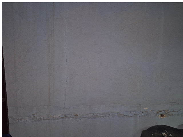
Zdj. 13 i 14 Pom. techniczne nr 2 - rysy i pęknięcia (m. in. 2,4cm) wraz z uszkodzeniem ciągłości warstwy tynkarskiej
