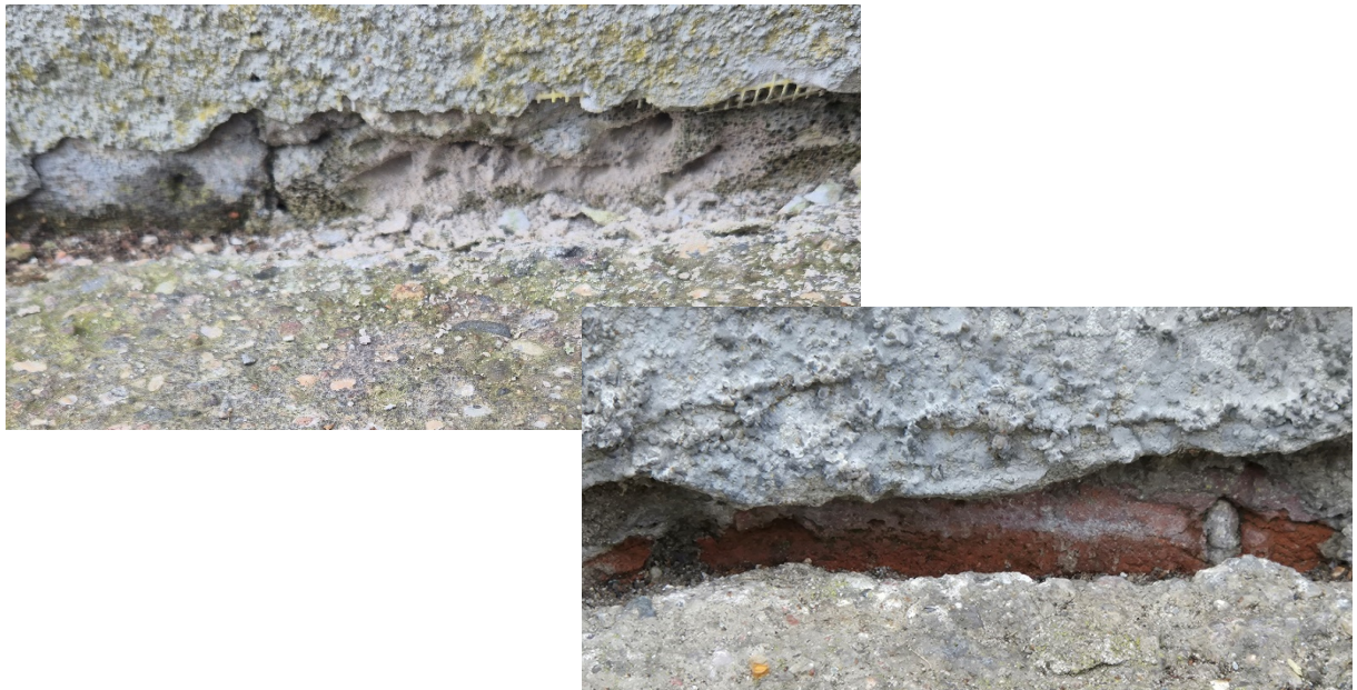
Zdj. 8 i 9 W obrębie cokołu i ściany fundamentowej stwierdzono obecność elementów murowych w postaci bloczków z autoklawizowanego betonu komórkowego (gazobetonu) oraz cegieł.
