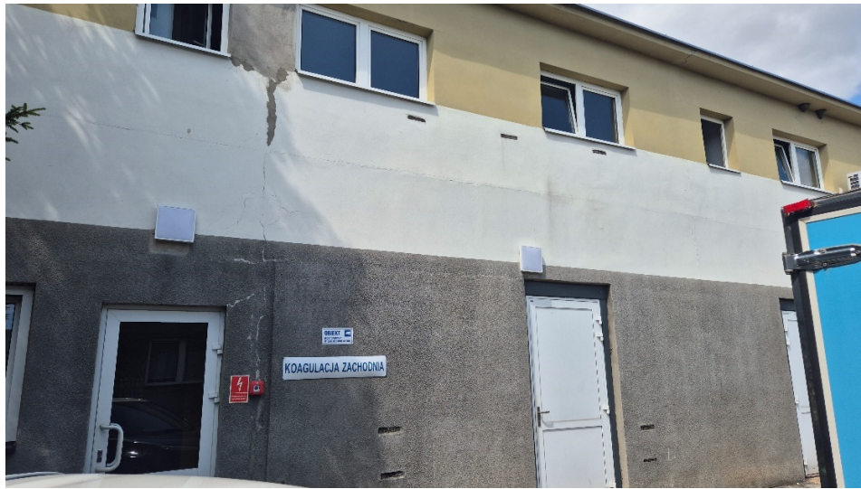
Zdj. 1 Elewacja frontowa, pęknięcia i rysy.
