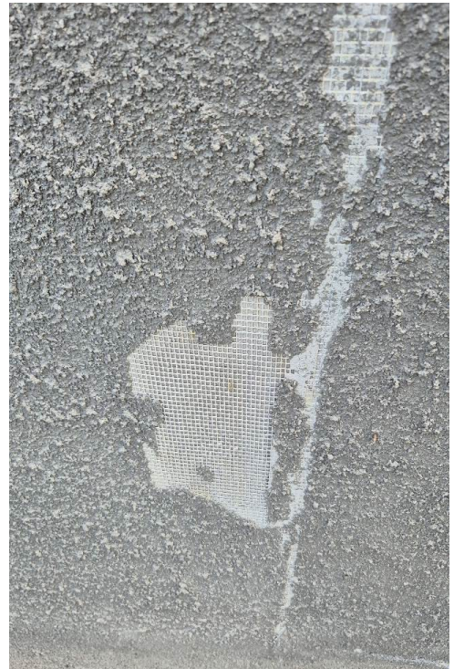
Zdj. 5 Pojedyncze ubytki tynku na budynku, widoczna siatka elewacyjna
